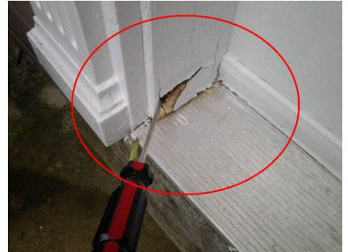
Lower exterior trim/frame
